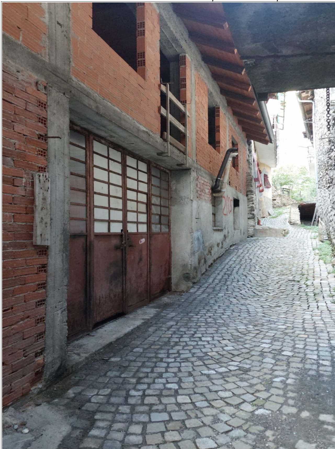
foto n.2 – vista esterna del lato sud delle u.i.u. ai piani terreno e primo
