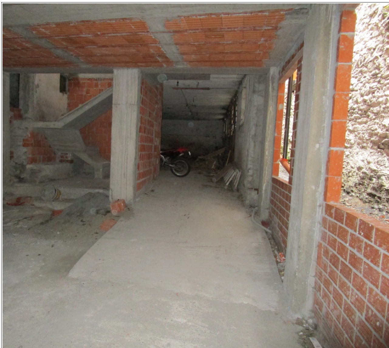
foto n.4 – vista interna al piano terreno delle u.i.u.
